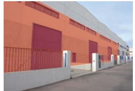
Außenwandabsicherung in einer kommerziellen Einrichtung/einem Büro oder im Privathaus
